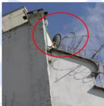
Aunque la Unidad Residencial cuenta con un buen esquema perimetral de protección, la cerca eléctrica superpuesta a las barreras, no se encuentra en funcionamiento - activa. De igual forma existen partes donde las rejas metálicas se encuentran en mal estado.
