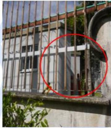
Las rejas por la parte externa de la zona perimetral oriental, por condiciones de tiempo, la lluvia, el sol y falta de pintura anticorrosiva, ya se encuentran deterioradas, las cuales no se descarta que puedan ser violentadas con facilidad, por personas, grupos y bandas delincuenciales con fines delictivos. De igual forma maleza y las plantas de swinglea cubriendo las rejas y concertinas, como se puede apreciar en las fotografías.
